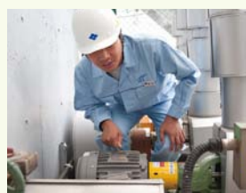
排水处理场的水泵更换成ECO水泵
