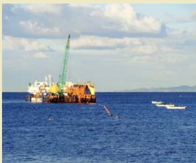
海底电缆铺设工程的状况
