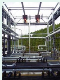
吉舍工厂的污水处理装置
