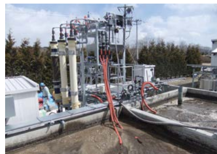
外置式简易POREFLON™MBR装置
