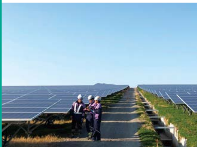
大型太阳能发电站的施工场景
