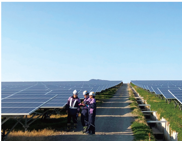
大型太阳能发电站的施工现场
