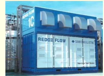
レドックスフロー電池
