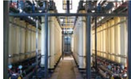
四川省簡陽市石盤鎮汚水処理場に納入された当社製水処理膜モジュール
