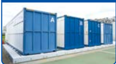
レドックスフロー電池
