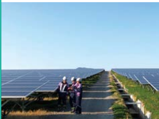
メガソーラーの施工のようす
