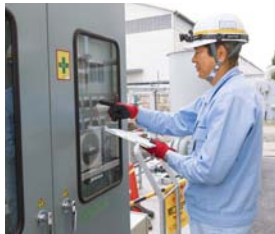
装置の稼働状況を点検
