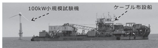
写真1 100kW小規模試験機へのケーブル布設状況
