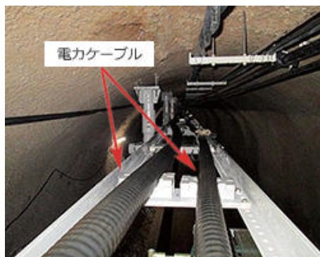
写真4 ケーブル布設状況
