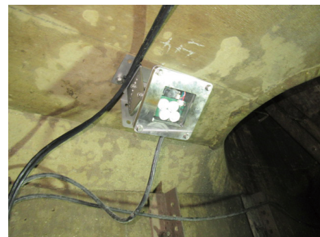
写真2 MH内へのカメラの設置例
