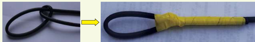
先頭のケーブルで輪を作り結ぶ
