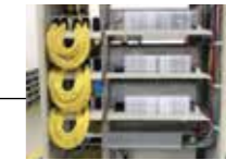
背面側でUターン配線。コード余長をクロス無く処理が可能。
