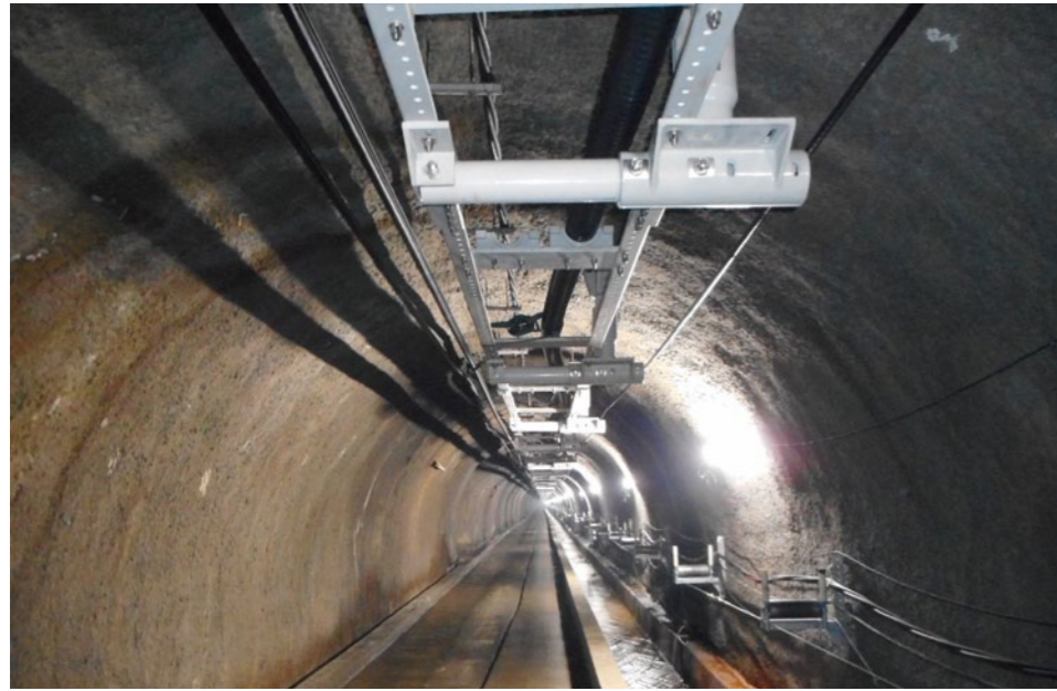
引入後、天井部へ設置した支持材上へのケーブル収納状況
