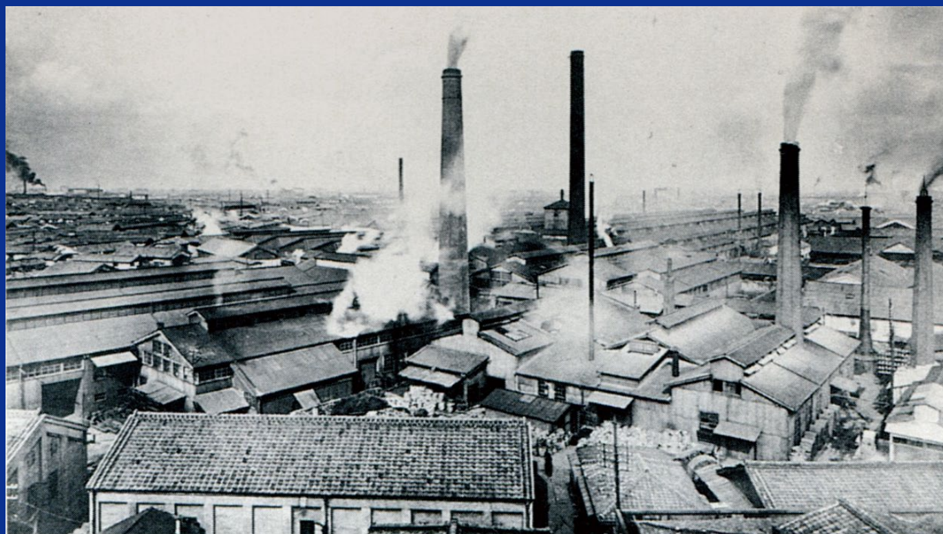
住友伸銅場（安治川）全景（写真提供：住友史料館）
