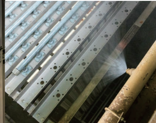
メンテナンスで洗浄されるポアフロン®モジュール
