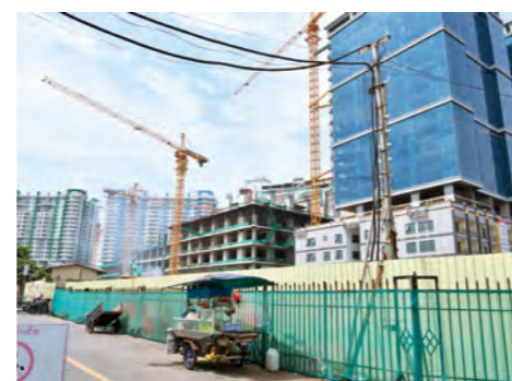
プノンペン都内では、いたるところで建設ラッシュが相次ぐ
