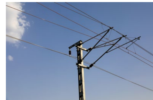
鉄道に電化の息吹を吹き込むトロッコ線とそれを支える電柱
