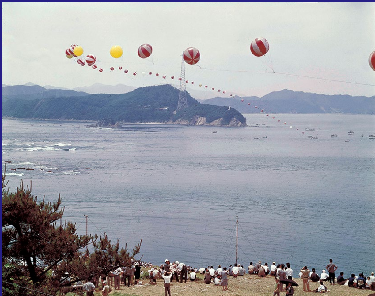
気球を使って送電線を対岸まで敷設する様子
