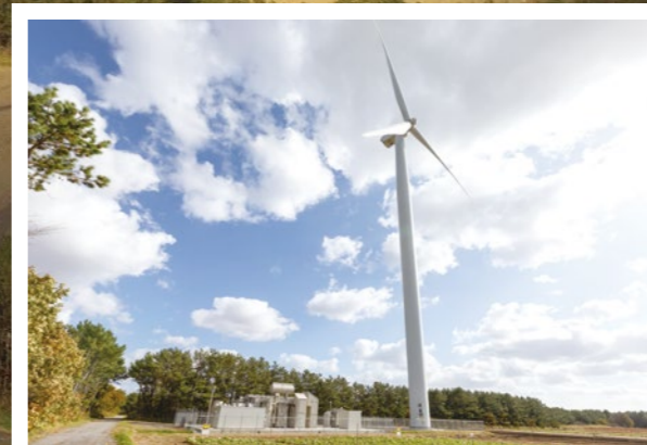
完成した風車と隣接する変電所
