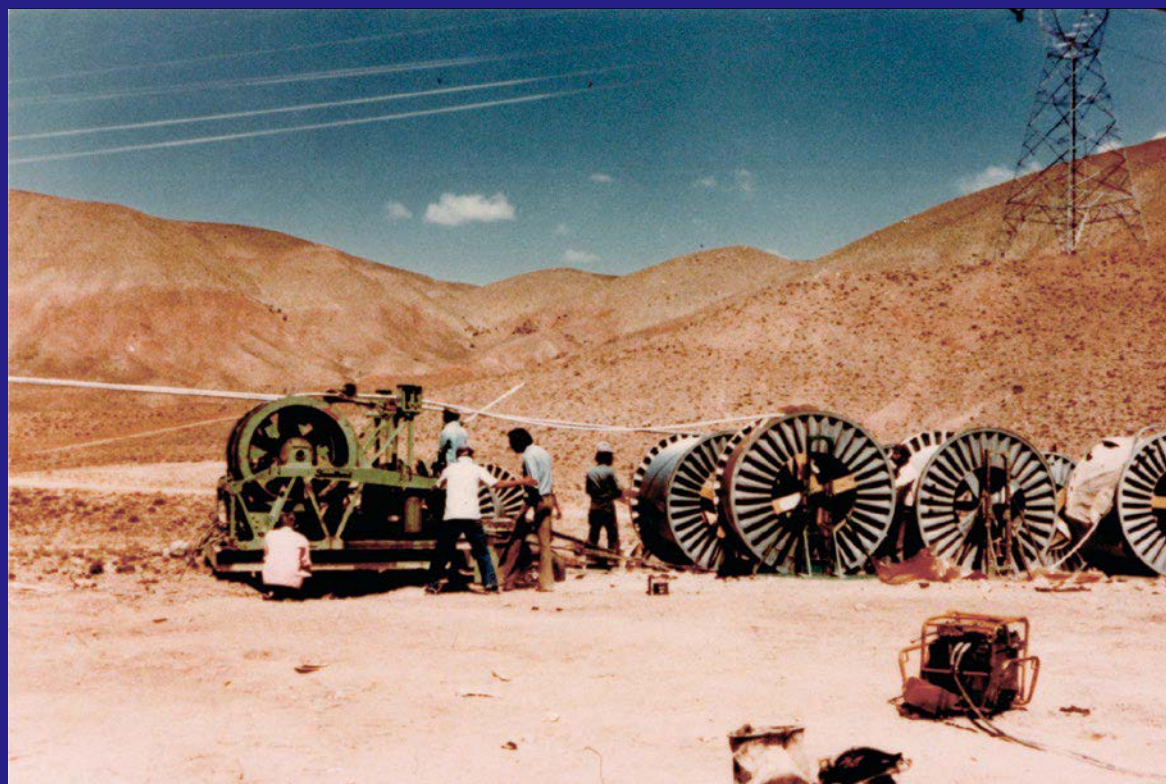
過酷な条件下で完成したイラン送電線工事風景
