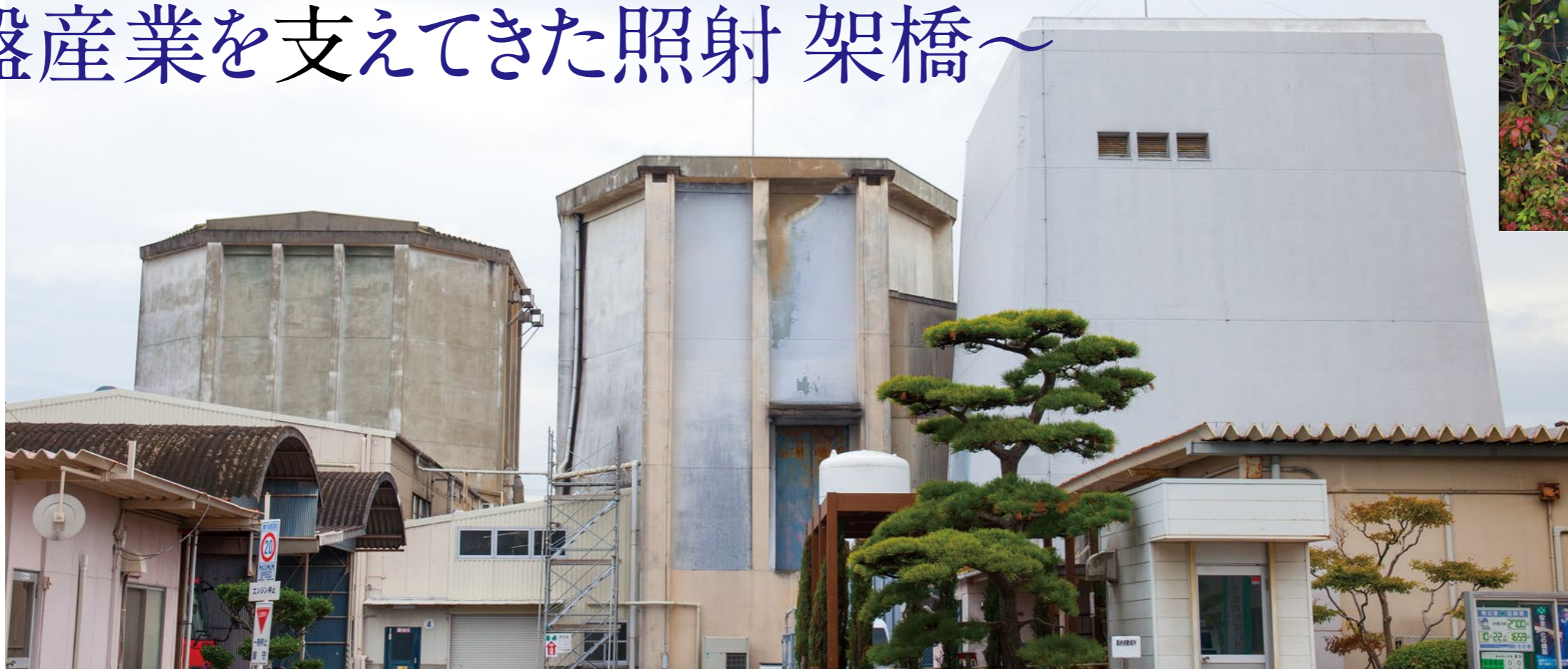
照射架橋装置を格納する建屋。左より1号機、2号機、3号機。住友電工ファイブポリマー(株)
