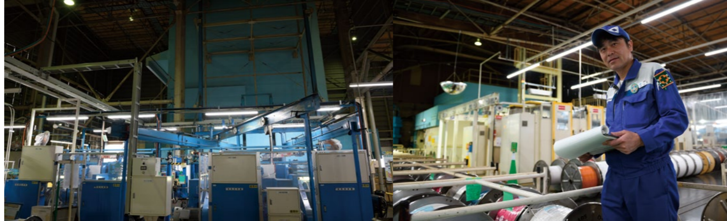
電子ワイヤー製造ラインと照射架橋装置(背景の青い建造物)。住友電工電子ワイヤー(株)
