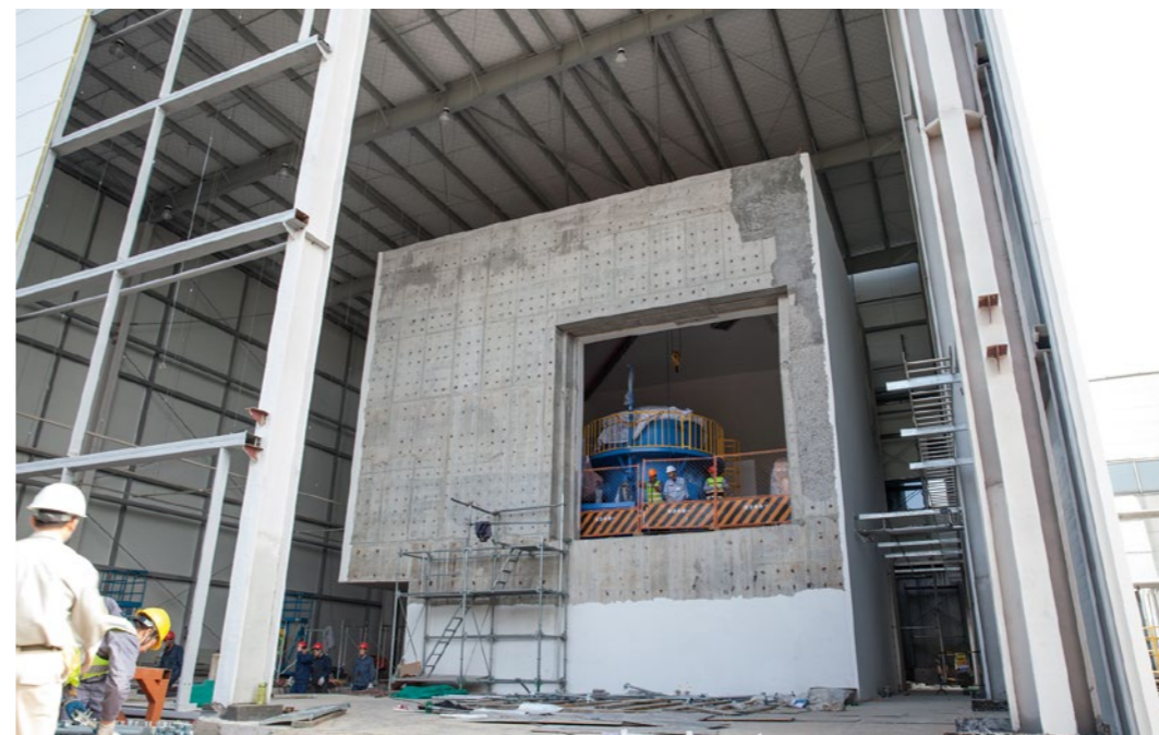
電子ワイヤー事業部の製造拠点、住友電気(蘇州)電子線製品有限公司。量産化の要請に応え、新たな照射架橋装置の設置工事が行われている
