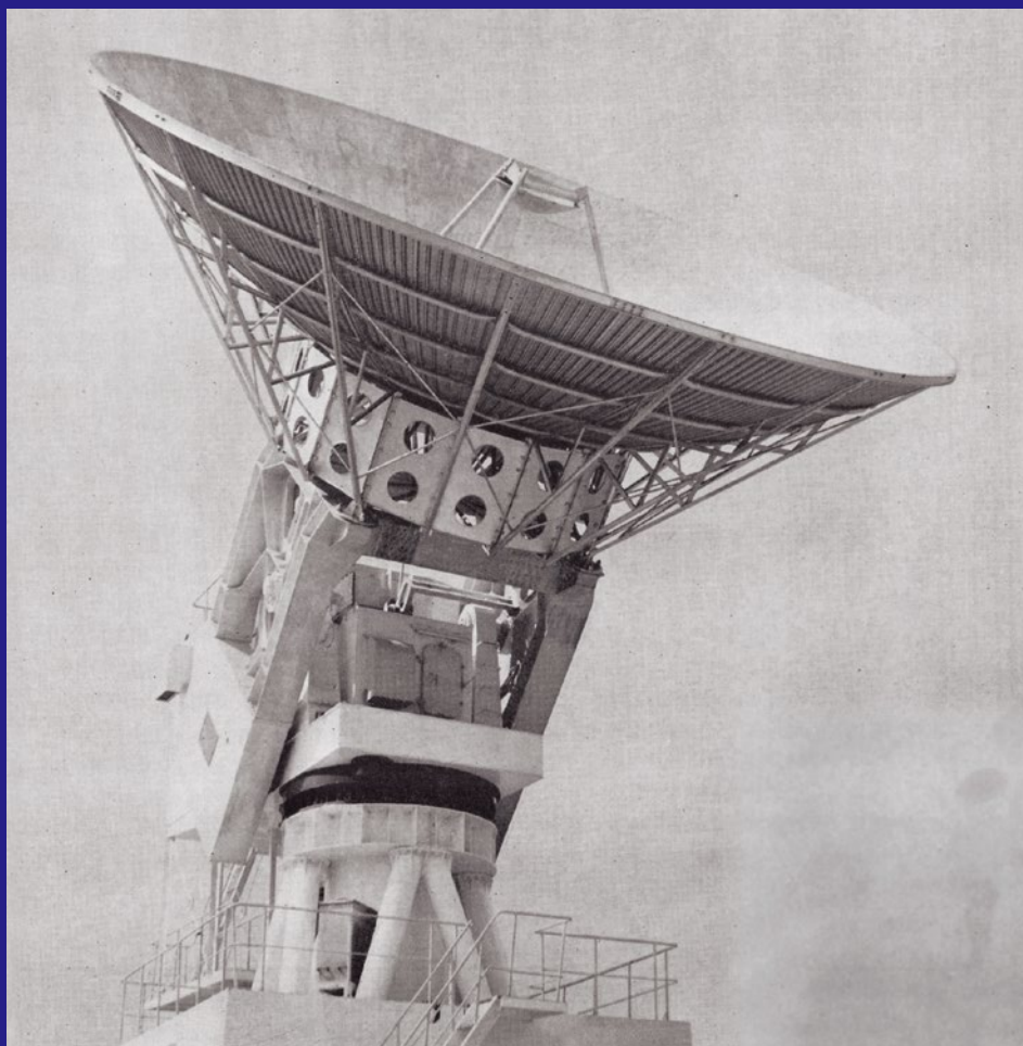
東京五輪をアメリカへ宇宙中継する茨城県鹿島町(当時、現・鹿嶋市)のシンコム衛星用のパラボラアンテナ(上のさかざき状の部分)
