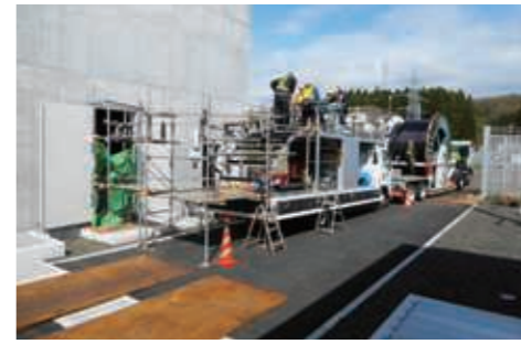
敷設風景（北海道側：吉岡ケーブルヘッド（引入口））
