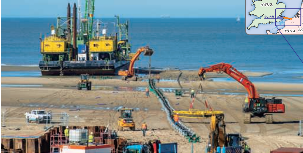
工事が進むベルギー側の海岸
