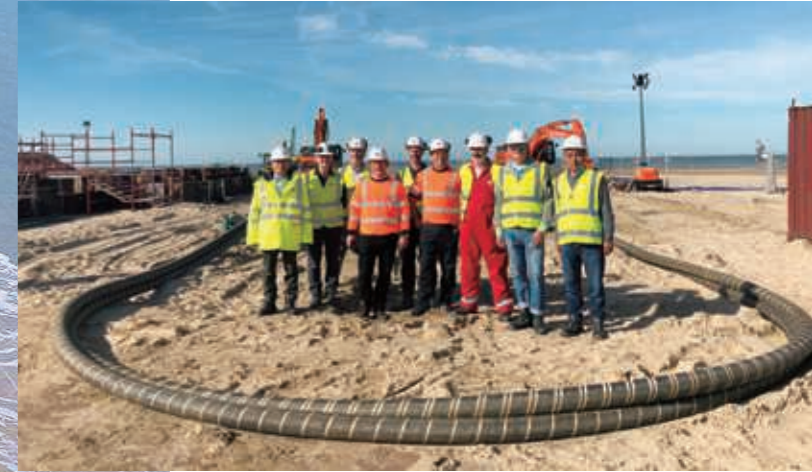
多国籍のメンバーが一体となって工事は進んだ
