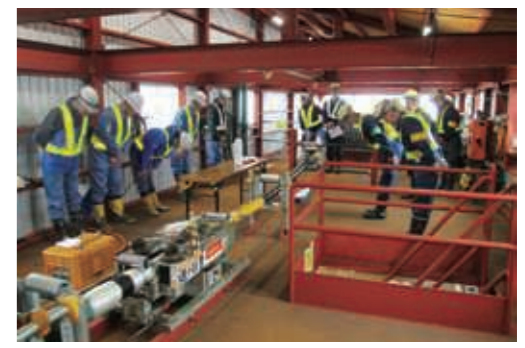
ケーブルの引入の様子（吉岡布設基地）
