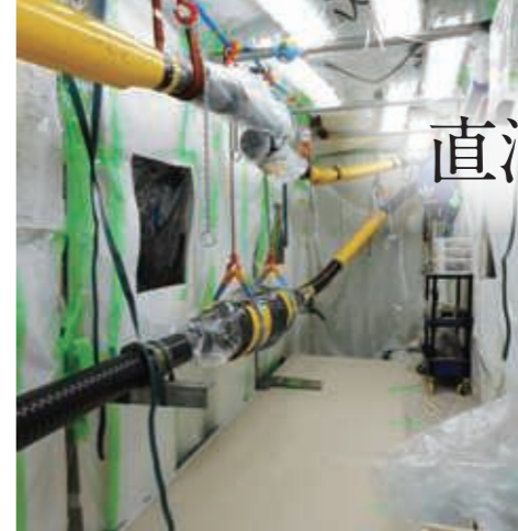
ケーブル接続作業室。過酷な環境下でも防塵対策に尽力した
