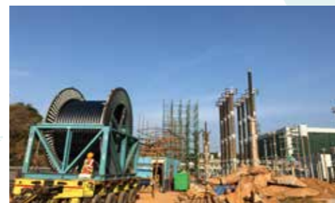
ケーブル布設の様子
