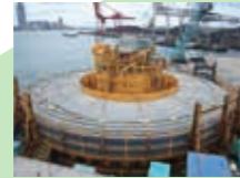
超高压直流 ケーブル
