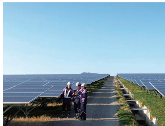
メガソーラーの施工のようす
