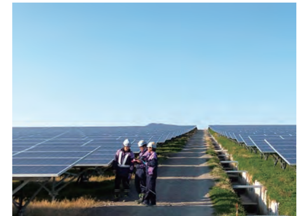
メガソーラーの施工の様子
