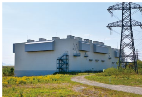
蓄電池建屋外観 2015年に北海道電力株式会社と共同で実施したレドックスフロー電池の大規模実証試験施設
