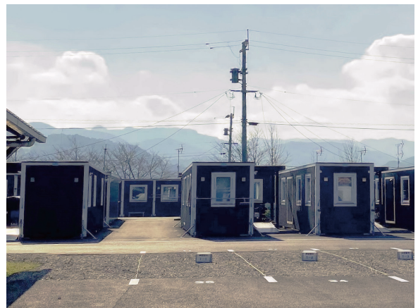
写真3 B地区 建設型仮設住宅
