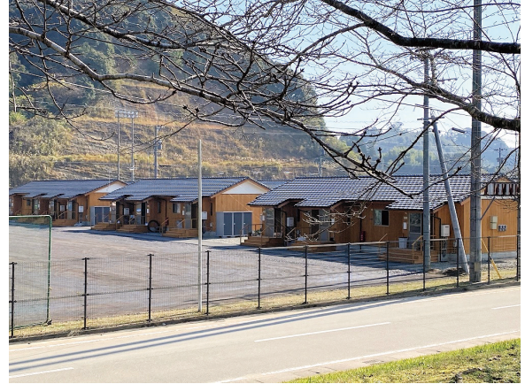
写真2 A地区 建設型仮設住宅
