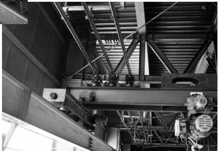
側面水平下向き布設例
